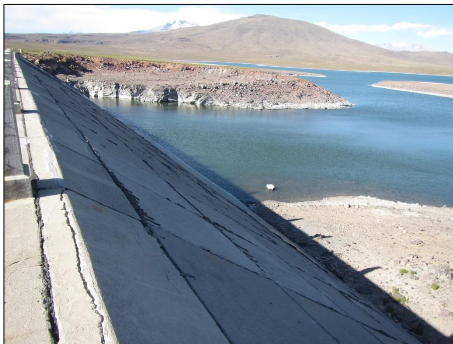
Figura 8.4: Muro embalse aguas arriba
