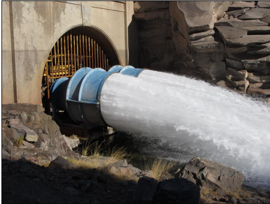
Figura 8.5: Tuberías de entrega
